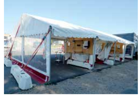
Sluseteltene har sikret, at personalet kunne stå i tørvejrs under alle vejrforhold.
