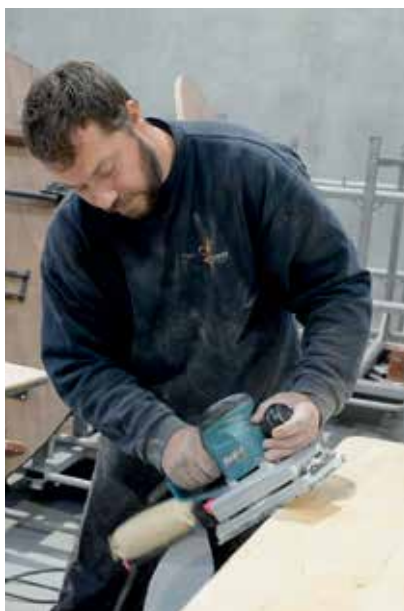
Den kæmpestore lagerhal giver plads til reparationsarbejde.
