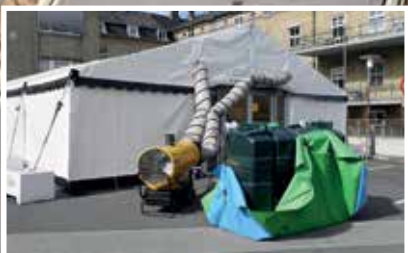
Store oliefyrr har været med til at sikre en ønskelig arbejdstemperatur i teltene.
