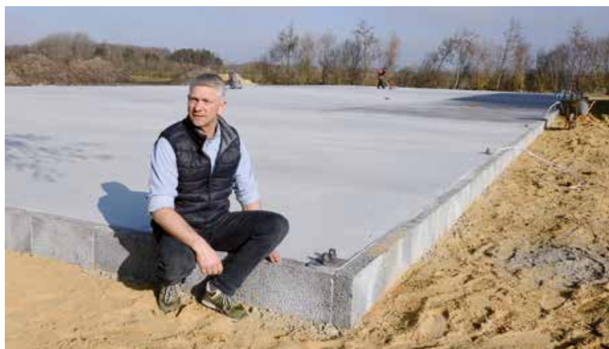
Svenning Kjær Pedersen ses her ved det ny støbte gulvareal til den nye lagerhal.
