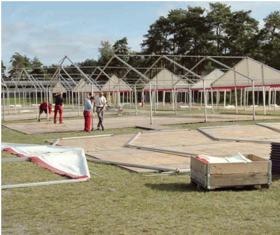
Det er umuligt at kontrollere, om et telt er certificeret, da der ikke er nogen sporbarhed på teltdele.
