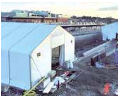
Store arbejdstelte opstilles af Halgruppen på danske arbejdspladser.
