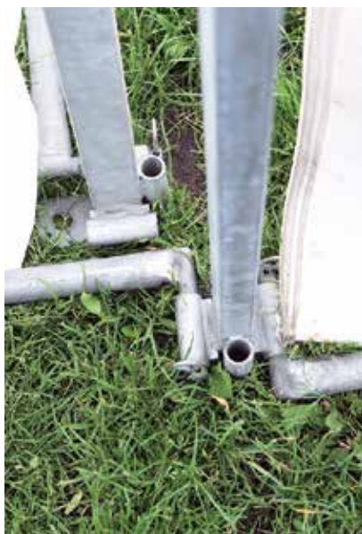
Alle ben skal have isat pløkker for at leve op til reglerne. Det var der ikke på opstillingen ved Langsøhus.
