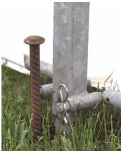
Pløkkene skal slås helt i for at overholde gældende regler.
