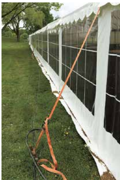
Afhængig af hvilke vindstyrker teltet er godkendt til, er der krav om barduner i alle ben.
