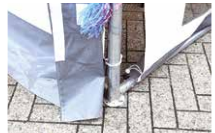
Manglende fastgørelse gør, at telte let bliver flyvende objekter til fare for de, der færdes omkring teltene.
