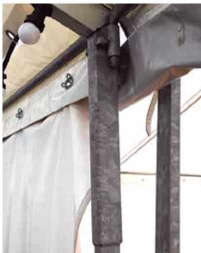
Teltkonstruktionen er hjemmelavede konstruktioner.
