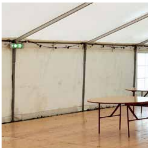
Ophængning af flugtvejsskilte må ikke ske på steder hvor der ikke er en reel mulighed for at komme ud.
