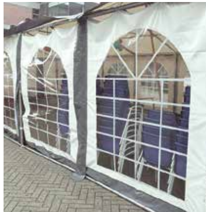
Teltdugene er ofte ikke lavet af brandhæmmende materiale og må derfor ikke bruges.
