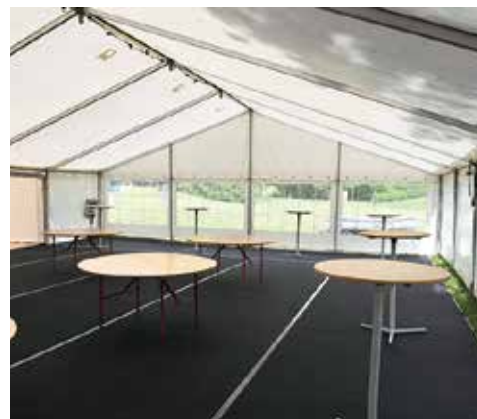
Påkrævede vindkryds i teltets top, si- derne i enderne og på langsiden var ikke monteret.
