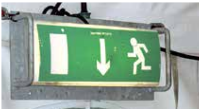
Der skal ophænges UD-lamper ved alle nødudgange i telte til over 150 personer. De skal findes ved re-certificeringen når telte skal godkendes til over 150 personer.
