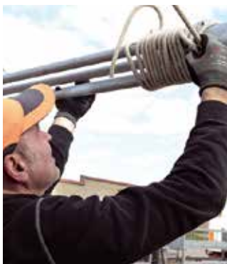
På denne akse føres trækrebene over med tagdugen.
