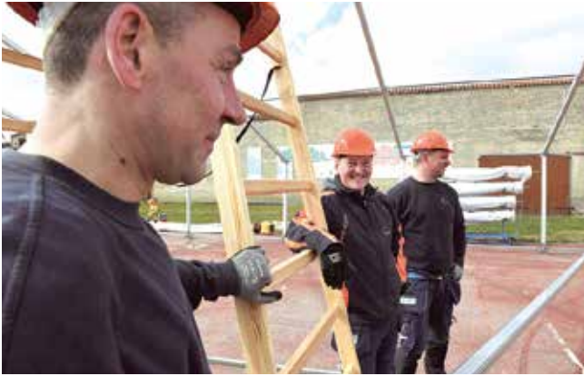
En wienerstige er der stadig brug for, da åsene skal placeres i toppen.
