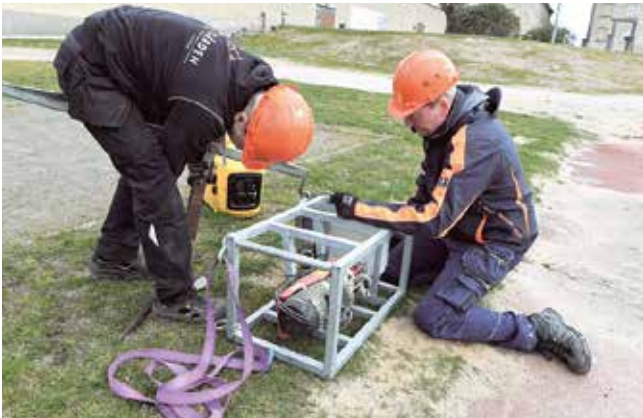
Rammen, som spillet er fastgjort i, sikres med store pløkker, så det står fast og er sikker under hele processen.
