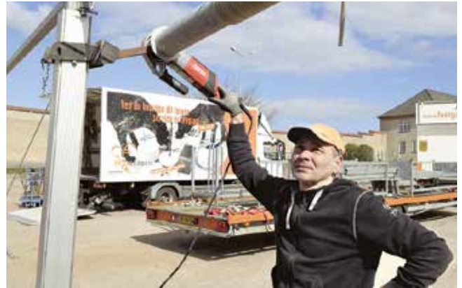
Med en rørskæremaskine i den ene hånd og den anden hånd i lommen, trækkes tagdugene over.
