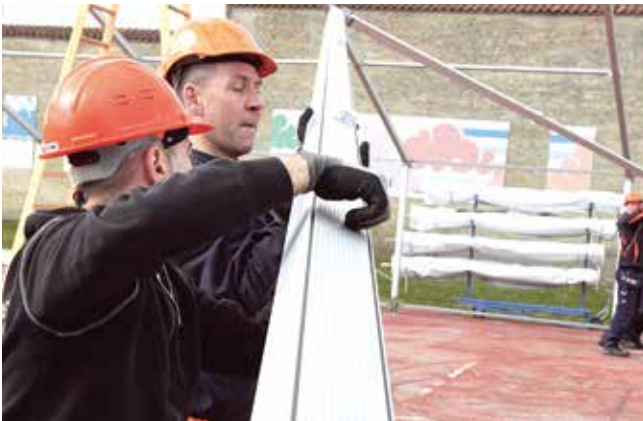
Spæret skal kun lige løftes op i en begrænset højde og spillet klarer resten.
