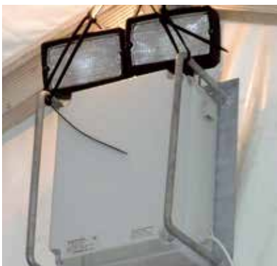
Paniklys skal ophænges i alle telte til over 150 personer. Antallet er afhængig af teltets størrelse. De skal findes ved re-certificeringen når telte skal godkendes til over 150 personer.
