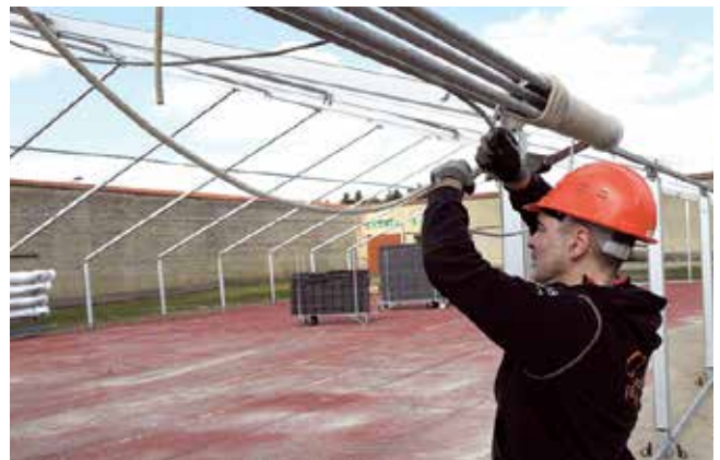
Et returreb gør, at man er fri for kast med trækrebene, når de skal retur.
