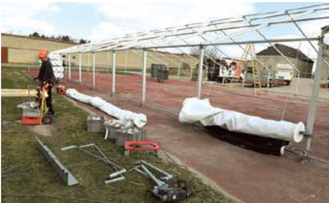
Tagdugge på holdere gør dem lette at trække over og returnere. Begge processer laves af en rørsæremaskine.
