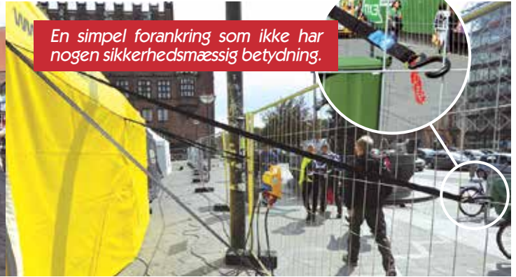
Et salgstelt som ikke er fastgjort overhovedet.
