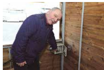
Det skal være let at installere el i salgsboden, hvorfor der er placeret en el installation.
