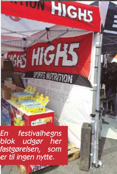
Opstillingsvejledningerne arbejder med fastgørelse pr. ben og ikke fælles fastgørelser som her, hvor vægtpåkravet til betonblokken vil være mange dobbelt.
