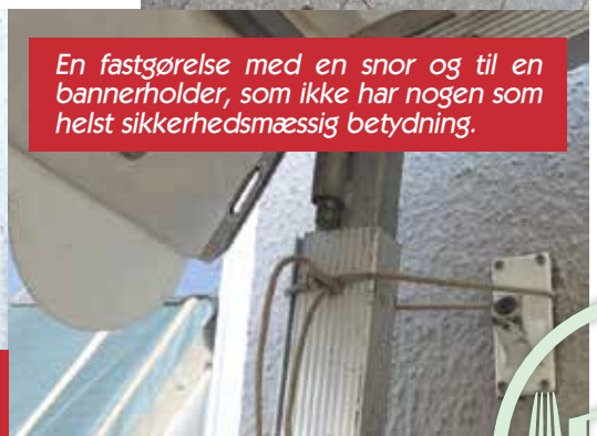
En fastsurring til et nedløbsrør, hvilket ikke har nogen betydning for, om teltet fastholdes, hvis vinden tager fat.
