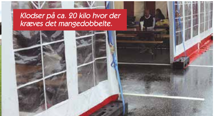
Mange glemmer, at når afstanden mellem to telte er under fem meter, er der tale om ét telt og helt andre regler.
