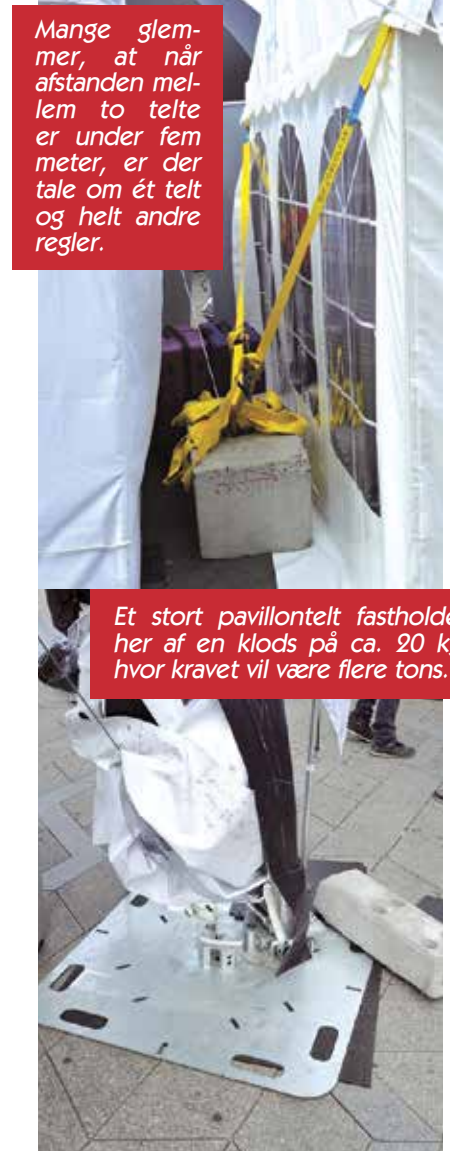
En fastgørelse med en snor og til en bannerholder, som ikke har nogen som helst sikkerhedsmæssig betydning.
