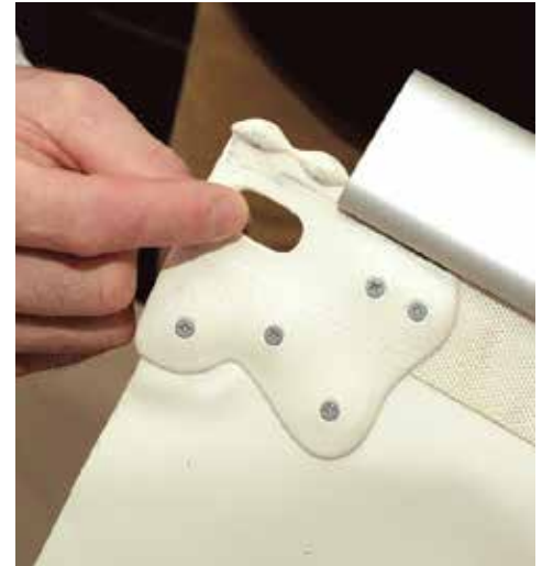
Kederen fastgøres med fem små skruer og er så klar til at beskytte tagdugen og vulstkanten. I kederen er der lavet et hul, så det er let at montere en trækrog heri.
