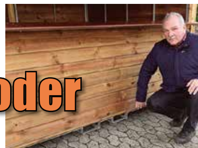
En af finesserne ved salgsboden er, at det nederste bræt kan vippes op og at en truck let og elegant kan læsse den sammenklappelige salgsbod.
