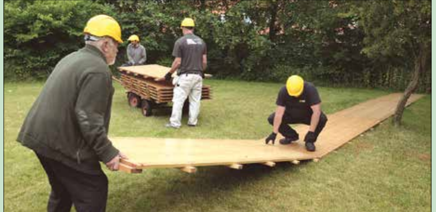
Ved transport og lægning af gulvplader skal man være meget opmærksomme på at undgå vrid.
