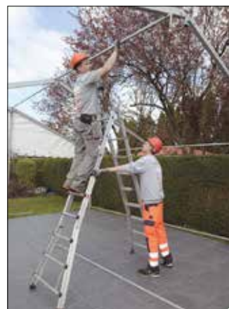
Ved brug af stige skal en "fodmand" sikre at stigen ikke vælter eller påkøres.
