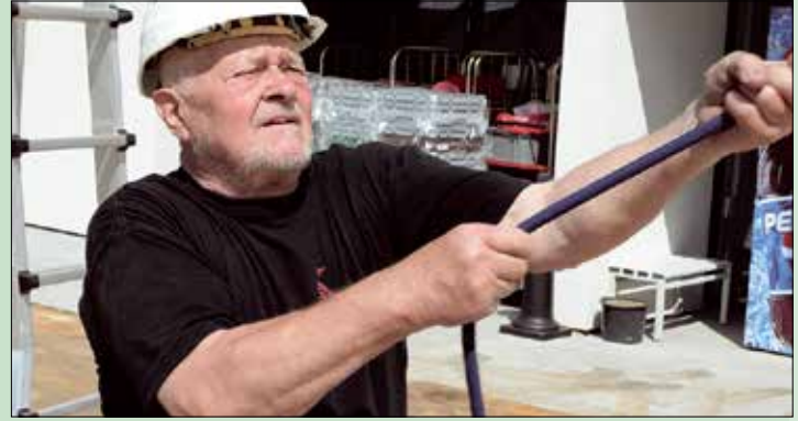
Ved mindre telte er det nok med én medarbejder til at trække. Ved bredere telte skal der min. to medarbejdere til trækket i hver side.
