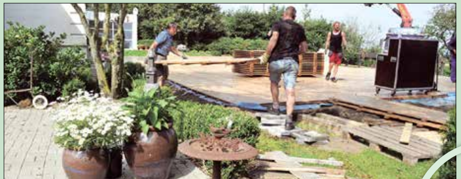
Sørg for, at terrænet er så jævnt som muligt og fri for forhindringer. En stor del af de arbejdsulykker der sker er, når folk snubler.
