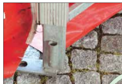
Masser af telte er blevet sat op uden at der har været banket pløkker i benene.
