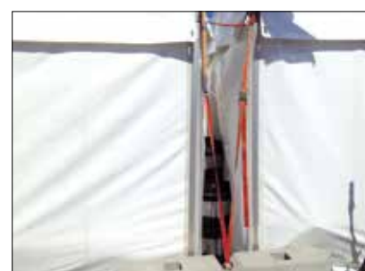
Ved at bruge den samme betonklods, opfylder telte ikke fastgørelseskravene.
