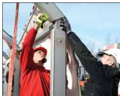
Monteringsarbejdet af tagduge kan være svært, hvis man ikke er så høj. Det er derfor vigtigt at have noget sikkert og let håndterligt at stå på.
