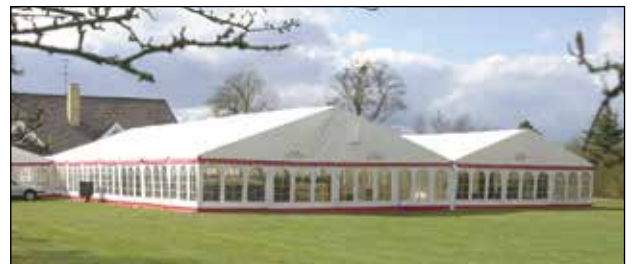
Det er nu tilladt at sammenbygge telte i forskellige bredder, når de kan fastgøres efter de krav der er i producenternes opstillingsvejledning.
