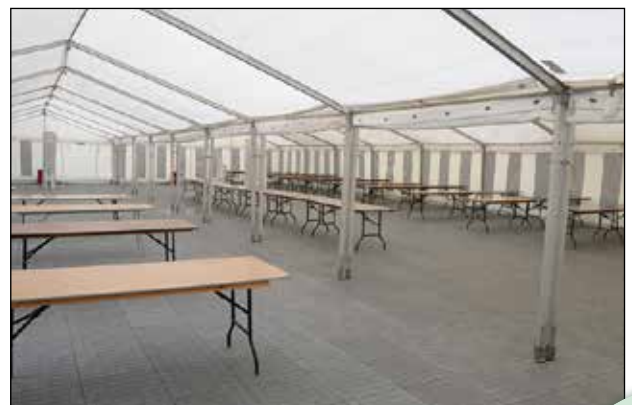
Det er ikke tilladt at sammenbygge telte, hvis det ikke er muligt at fastgøre benene i de to teltsider der går mod hinanden. Kun opstilling af betonklodser inde i teltet vil kunne løse problemet.
