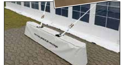
Et nyt tiltag med hætter til overdækning af betonklodser blev præsenteret.
